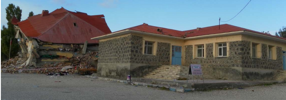
Şekil 4.71 – Gedikbulak İlköğretim Okulları'nın genel görünümü
