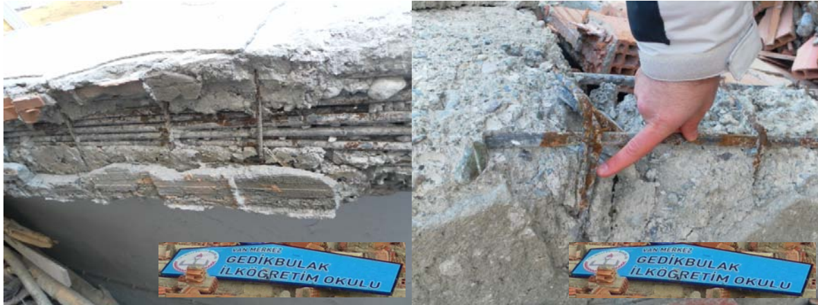
Şekil 4.76 – Gedikbulak İlköğretim Okulu'nun kısa yöndeki perde duvarları
