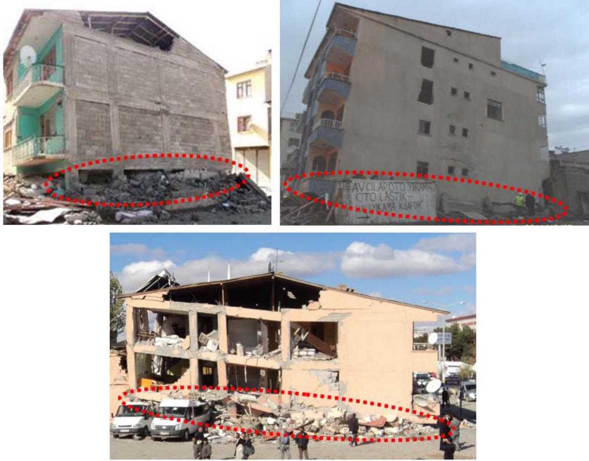
Şekil 4.25 – Zemin katta ani rijitlik değişimi bulunan göçmüş binalar
