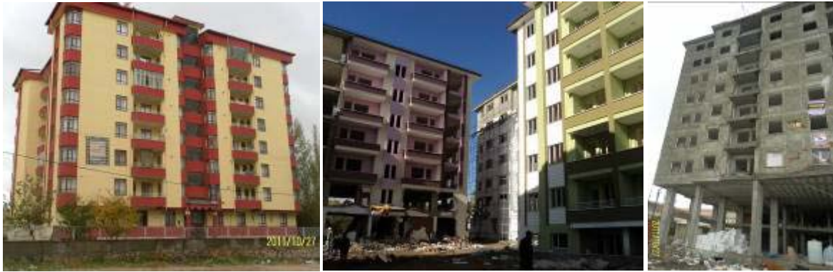
Şekil 4.1 – Van-merkez ve Erciş'te bulunan tipik çok katlı betonarme binalar
