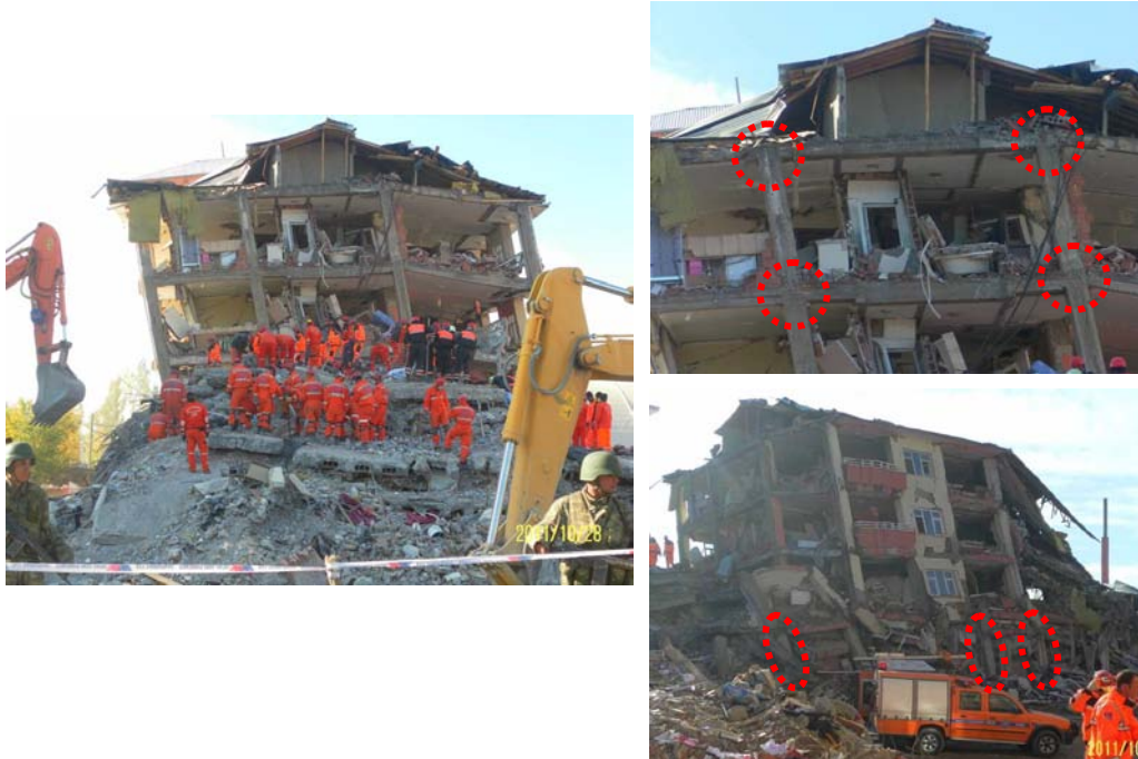
Şekil 4.22 – Alt kat kolonlarında plastik mafsall oluşması sonucu ortaya çıkan stabilite problemi
