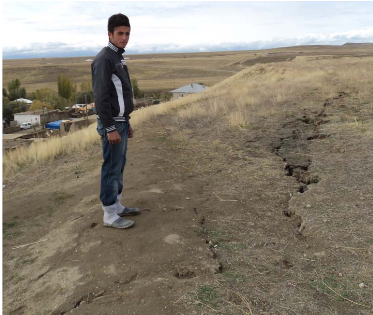
Şekil 3.4 – Dibekdüzü Köyü yakınlarında oluşan yer çatlağı
