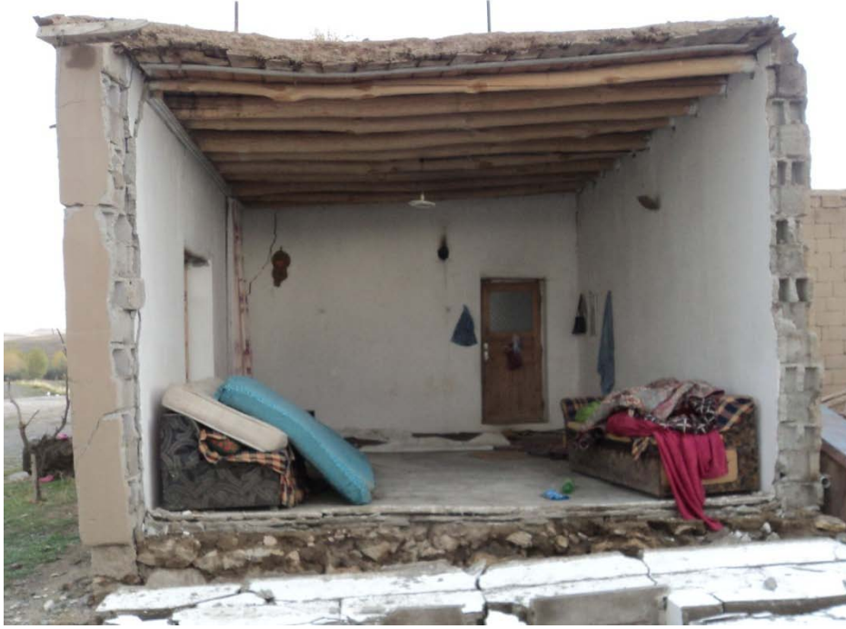
Şekil 4.29 – Bölgede bulunan tipik yığma yapıların kesit görünümleri
