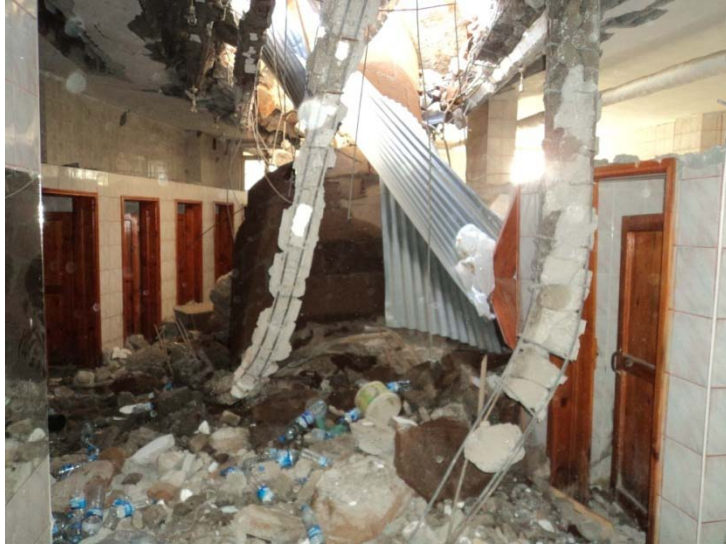
Şekil 4.81 – Erciş Van Yolu Camisi'nin yıkılan minaresi
