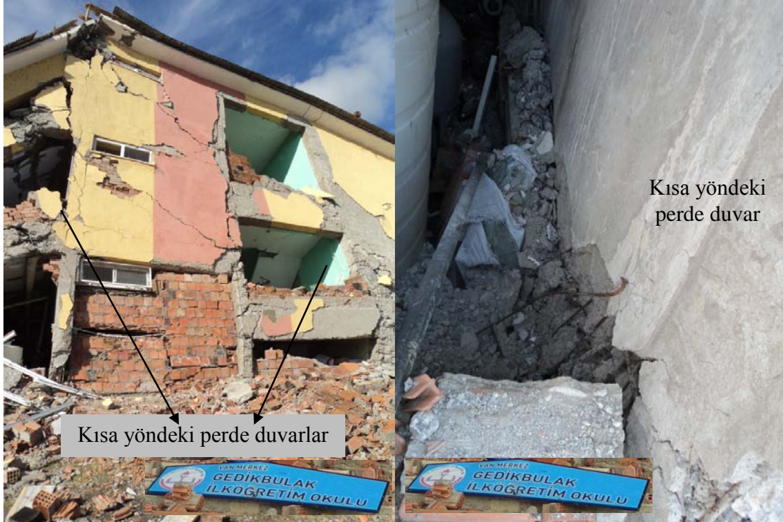
Şekil 4.76 – Gedikbulak İlköğretim Okulu'nun kısa yöndeki perde duvarları
