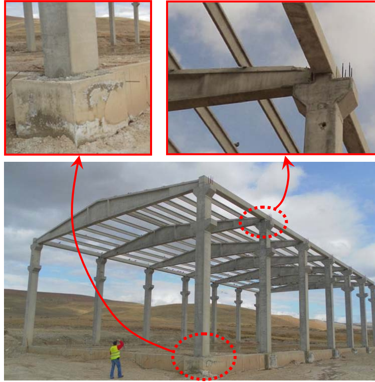
Şekil 4.27 – Depremde hasar almamış bir prefabrik betonarme yapı çerçevesi
