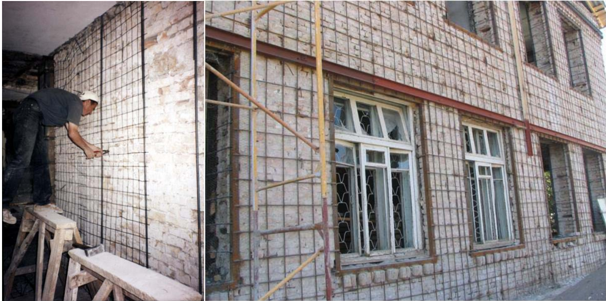
Şekil 4.38 – Çapraz çatlakları önleme teknikleri (Khakimov vd., 2007)
